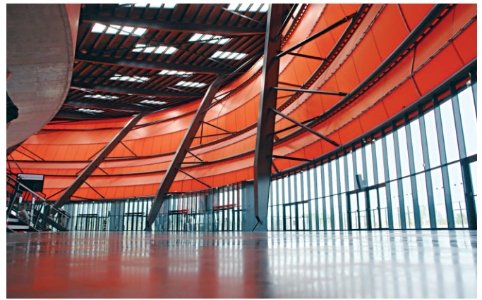
Bild 2. formTL entwickelte mit den Architekten Massimiliano und Doriana Fuksas eine Kehlseil-Lösung zur Umsetzung der komplizierten Geometrie (Fotos: formTL/Optima, Strasbourg)
